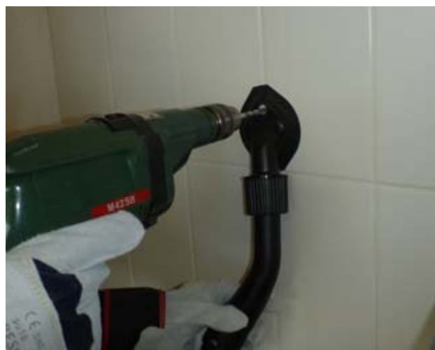
4 Trapano con aspirazione alla fonte durante l'uso su piastrelle con colla contenente amianto.
